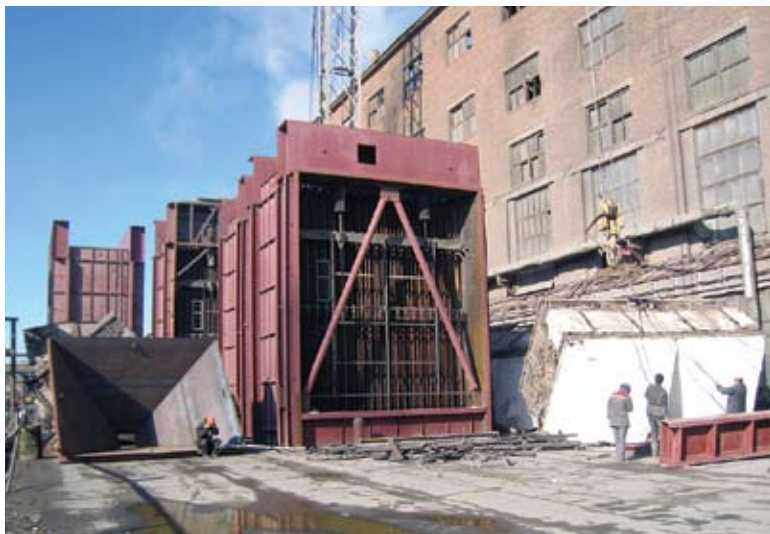
Забора об экологии у новотроицчан - на первом месте. Идёт установка электрофильтра, который значительно снизит вредные выбросы в атмосферу.
