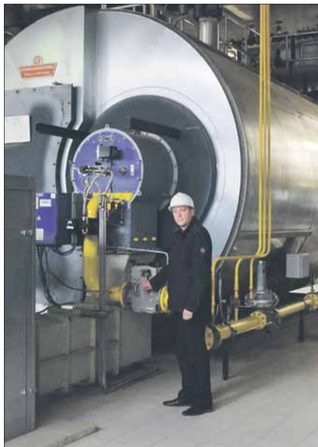
Начальник ПТО Александр Козлов осматривает оборудование.
